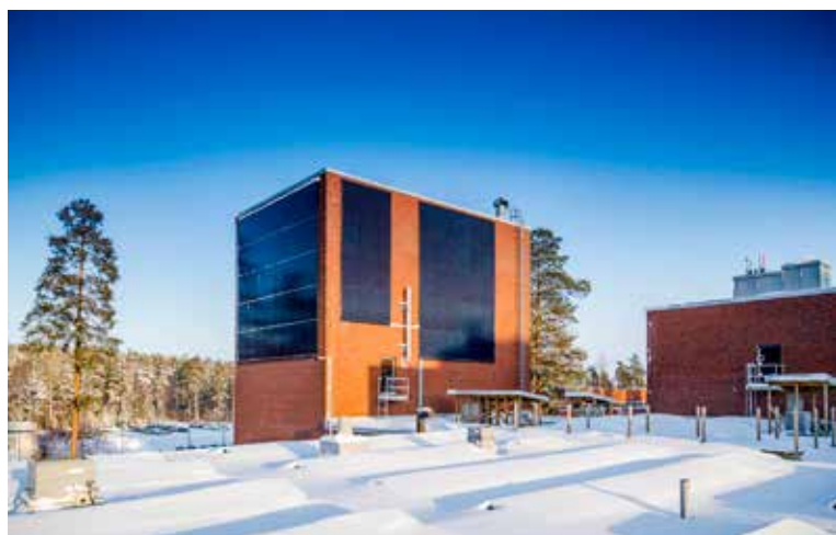
Aurinkopaneelien asennus Lappeenrannan yliopiston rakennuksen seinässä. Kuva: Teemu Leinonen, LUT.
