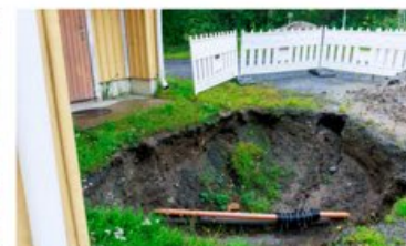
Kevättalvella auki kaivettua monttua ei ole vielä täytetty.
