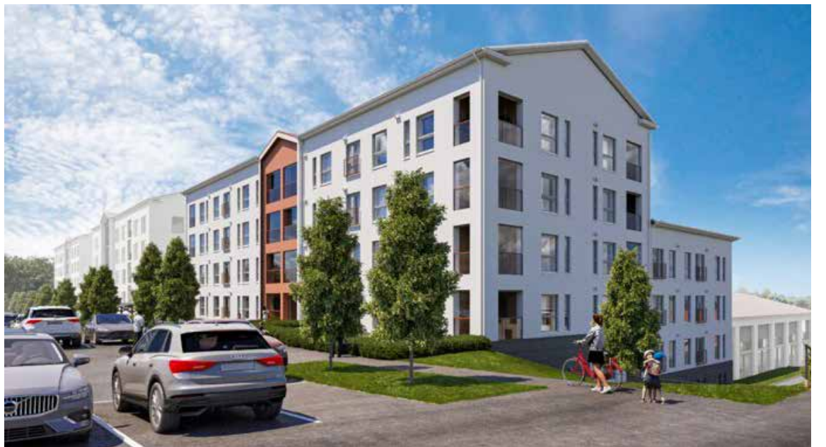
Sevas Kodit Oy:n vuokratalo. Jykevä talo vanhan sairaalarakennuksen tyyliä. Arkkitehtitoimisto Granlund Oy. 73 asuntoa. Asukkaat muuttavat tammikuussa.
